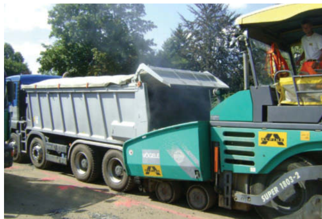
Durch das dosierte und kontrollierbare Abschieben ist dieses System hervorragend für den Asphaltbau geeignet
